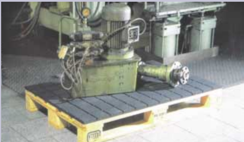
Colocación de apoyos intermedios debajo de agregados
